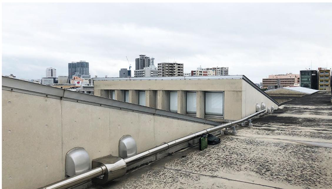
図-6 屋上に設置された天窓とそのための斜め屋根
