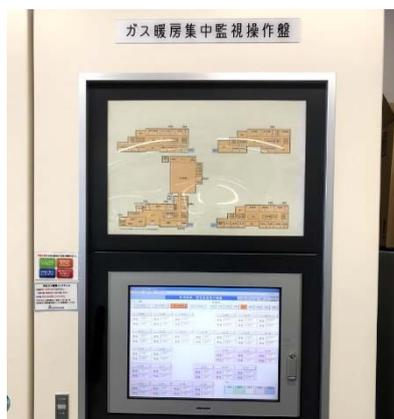
写真 2.4 ガス暖房集中監視操作盤
