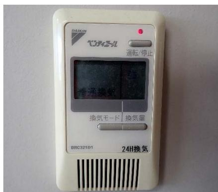
写真 2.5 全熱交換器の設定機器
