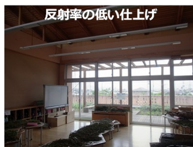
図 3-52 仕上げの反射率の違いによる明るさの感じ方の違い
