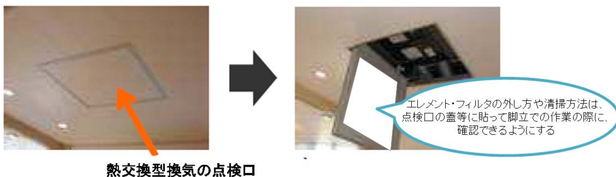
図 3-8 熱交換型換気の点検口
