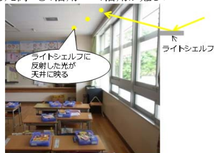
図 3-34 ライトシェルフを用いて光の動きを可視化する仕掛け(例)
