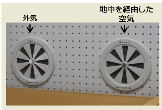
図 3-41 温度の違いを比較できる給気口
