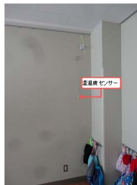
図 5-7 廊下の温湿度センサー
