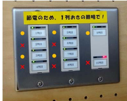
図 3-28 電灯照明スイッチの例
