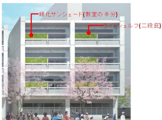
図 3-14 日射遮蔽装置
