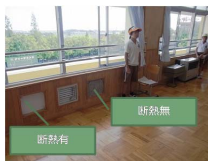
図 3-36 断熱の有無を比較できる壁 豊田市立土橋小学校
