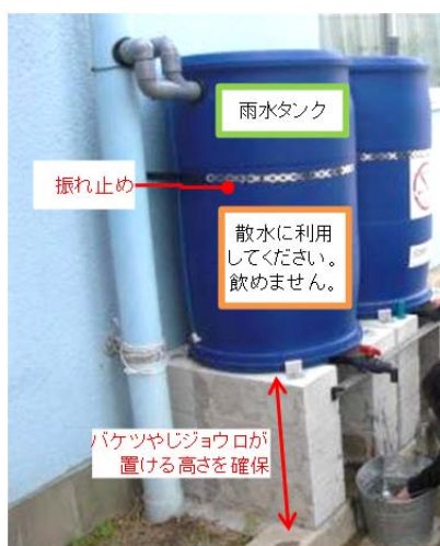
図 3-16 雨水タンク設置例
