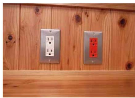
図 3-51 太陽光発電コンセント(例)
