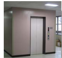
エレベーターの設置
