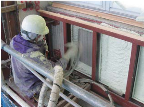
福井県若狭町立三方中学校 4 ウレタン吹付 30mm(外断熱) +複層ガラス(カバー工法、アタッチメント工法)
