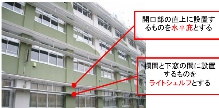
図 4.3.42 水平庇とライトシェルフ(写真は荒川区立第七峡田小学校 4) )
