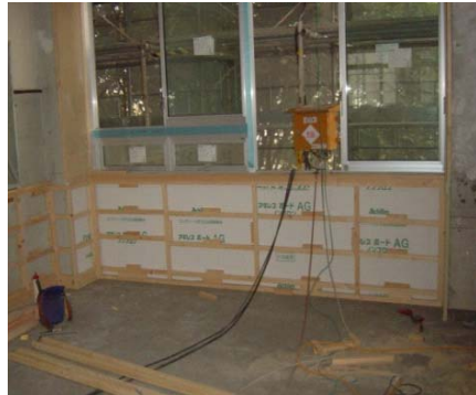
埼玉県立浦和高等学校 4 硬質ウレタンボード 30mm(接着工法) +杉羽目板 12mm +複層ガラス(カバー工法、下窓:ナイトパーズ用)
