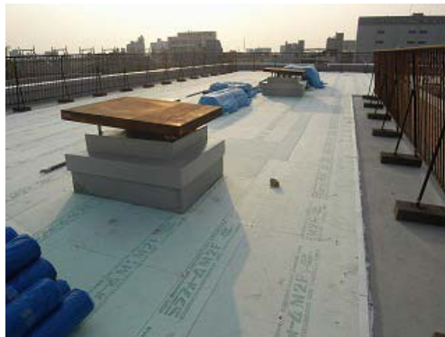
群馬県太田市立中央小学校 屋上断熱(押し出し法ポリスチレンフォーム 50mm)
