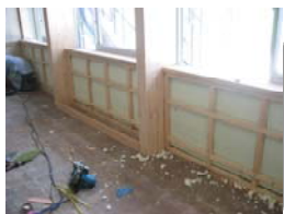
壁・屋上の断熱強化
