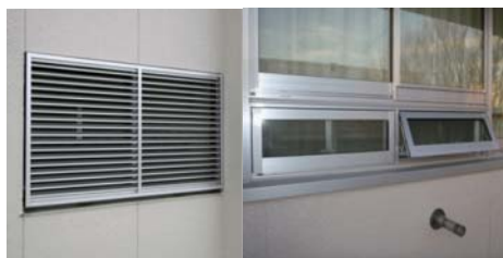
埼玉県立浦和高等学校 4 廊下のガラリ+教室の換気用窓 ※1
