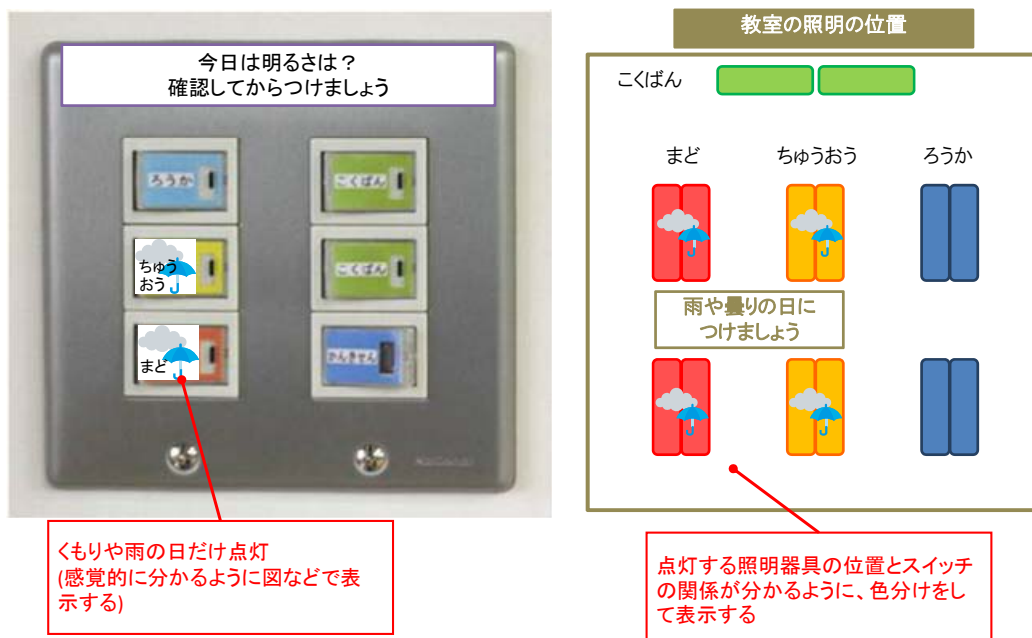
図 4.4.7 照明器具のスイッチの工夫(例)
