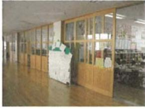
図 6.3.19 可動間仕切壁<sup>9)</sup>
